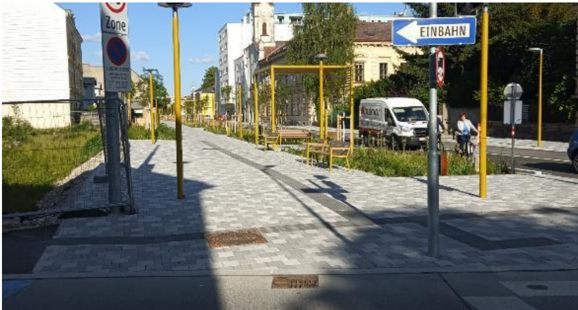
Abbildung 18: Gehsteigverbreiterung am neu gestalteten Promenadenring in St. Pölten
