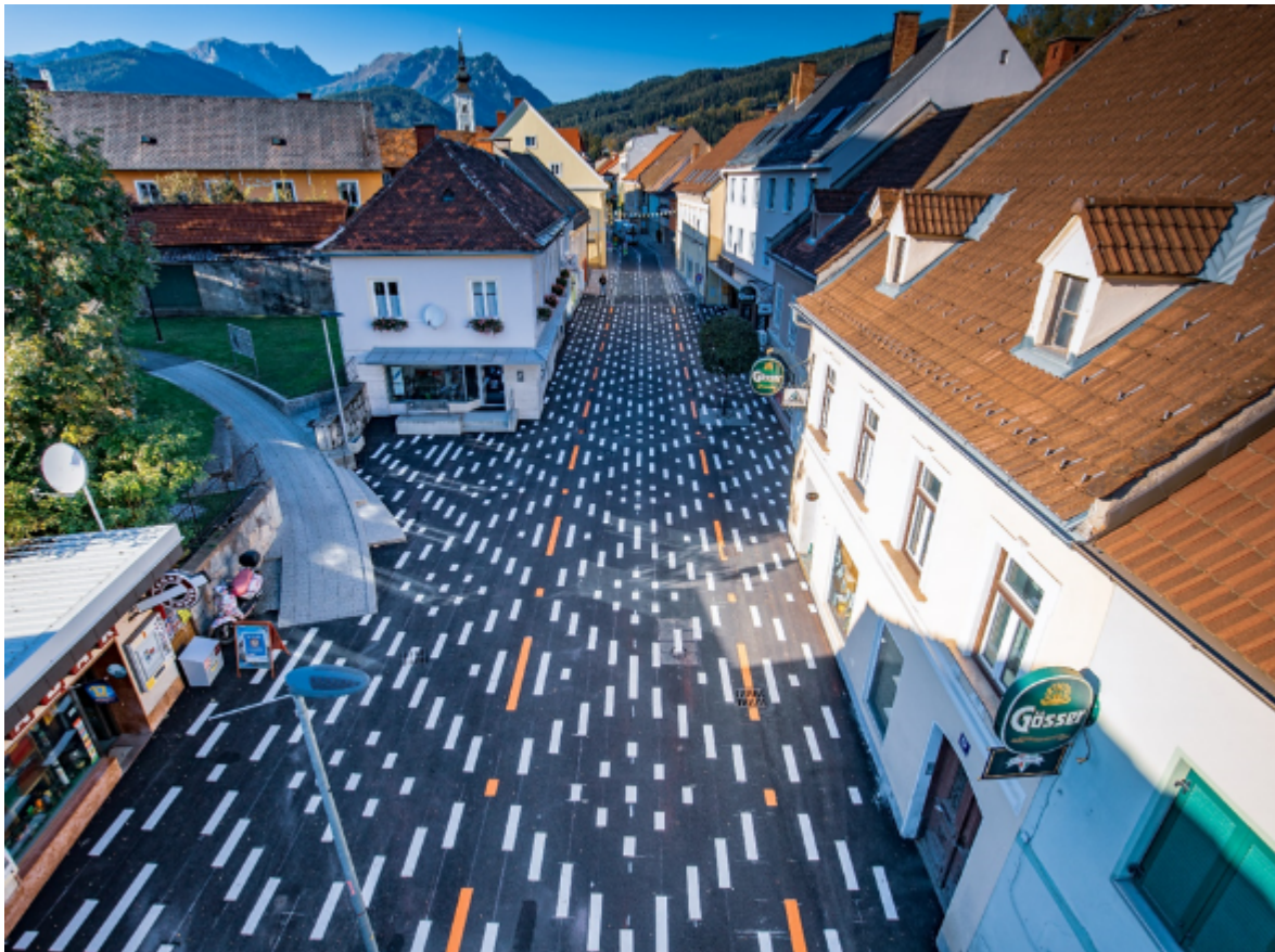
Abbildung 7: Neugestaltung der Hauptstraße in Trofaiach als Begegnungszone
