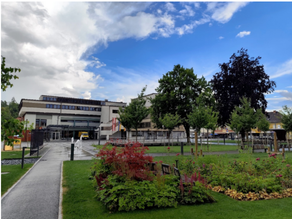
Abbildung 13: Umgestaltung des Schulumfelds in eine Fußgängerzone in Althofen
