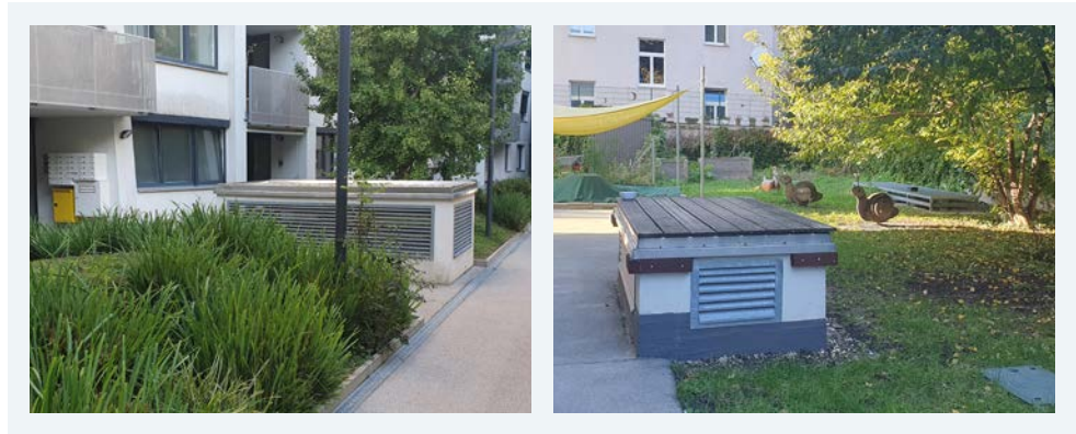
Abbildung 12: Grünraumgestaltung am Dach einer Tiefgarage eines Wohnbaus mit nutzbaren Abluftschächten in Wien, Bild: Österreichische Energieagentur/Irene Bittner
