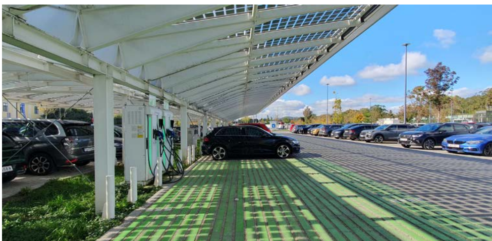
Abbildung 14: Pkw-Stellplätze mit PV-Anlage als schattenspendende Überdachung mit E-Ladestelle in Wien, Bild: Österreichische Energieagentur/Irene Bittner
