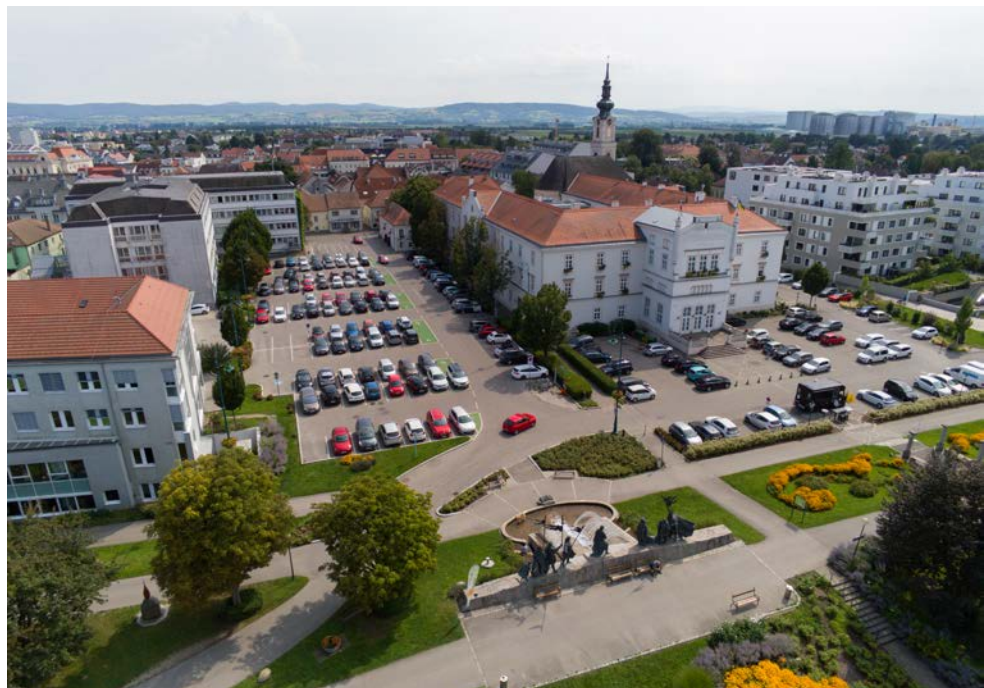
Abbildung 17: Nibelungenplatz in Tulln vor dem Umbau, Bild: droneproject.at
