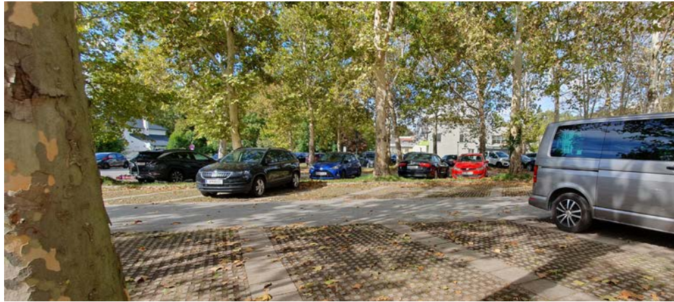
Abbildung 10: Altbaumbestand bei Pkw-Stellplätzen vor dem Kurzentrum Bad-Deutsch Altenburg (NÖ) mit ausreichend entsiegeltem Wurzelraum unter Rasenfläche und Betongittersteinen. Bild: Österreichische Energieagentur/Irene Bittner
