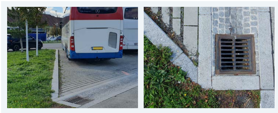
Abbildung 8: Versickerungsfähige Stellfläche mit offen verputzten, gebundenen Betonsteinpflaster und Entwässerung über Kanal, Bilder: Österreichische Energieagentur/Irene Bittner
