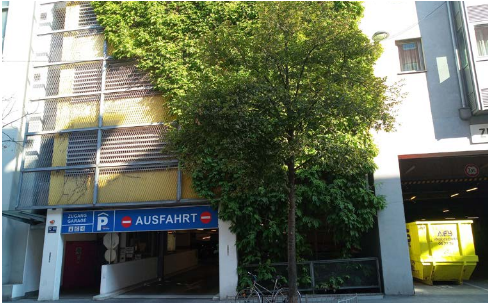
Abbildung 13: Parkhaus mit begrünter Fassade in Wien, Bild: Leo Kostka
