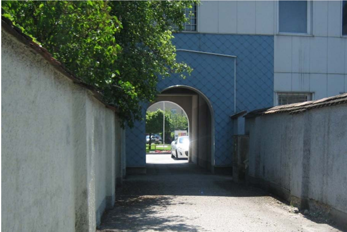
Abbildung 17: Sicherstellung der Durchlässigkeit für Zu-Fuß-Gehende in Attnang-Puchheim
