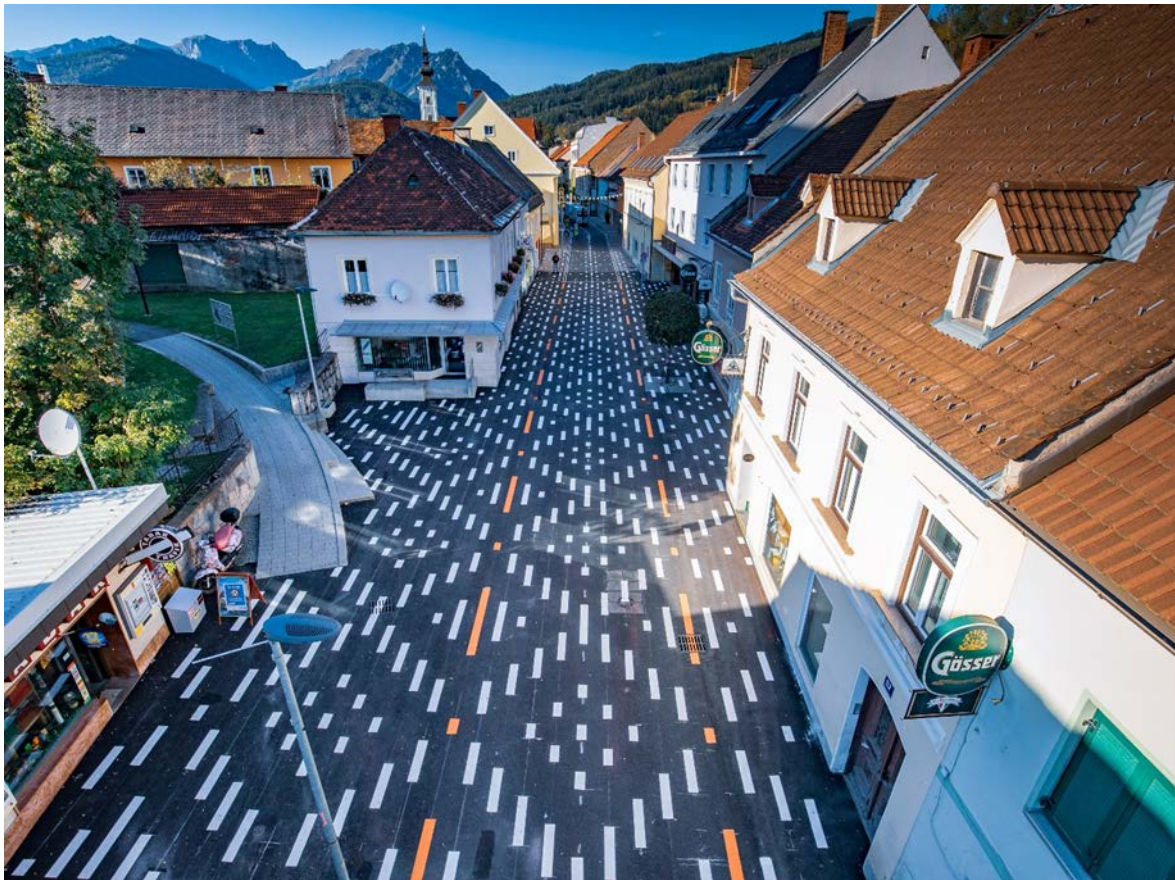
Abbildung 7: Neugestaltung der Hauptstraße in Trofaiach als Begegnungszone
