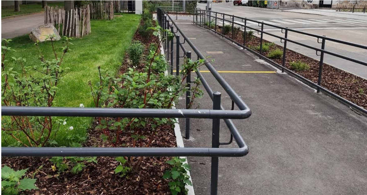
Abbildung 16: Barrierefreie Rampe im Kreuzungsbereich der Bernardgasse (Wien 7. Bezirk)
